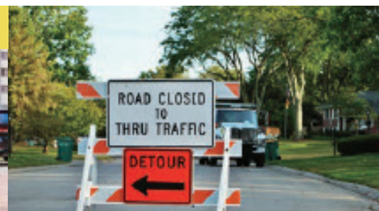
Señales de construcción
